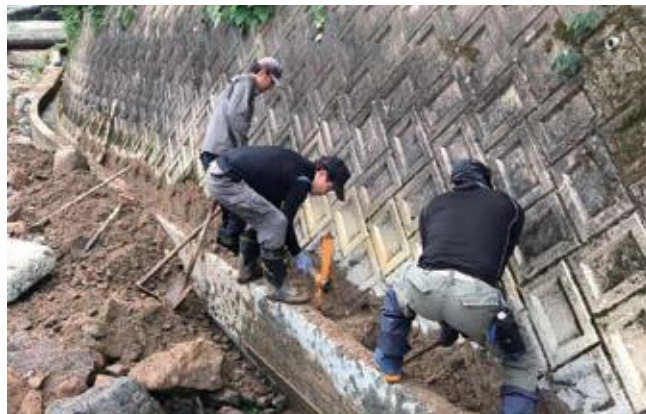
令和2年7月豪雨により土砂で埋まった水路の復旧作業
