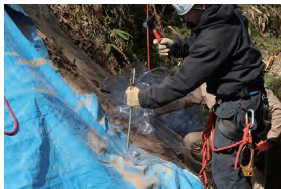
法面保護活動内にて試験資器材の仕様確認
