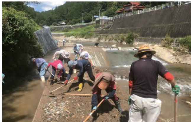
令和元年8月末の豪雨で埋まった水路の土砂出し作業を農家さんたちと協働で行いました
